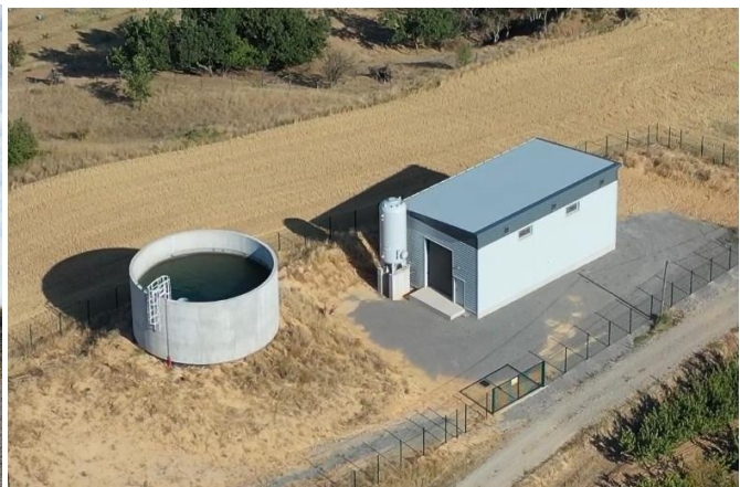
Réservoir et station de reprise des Roussons
