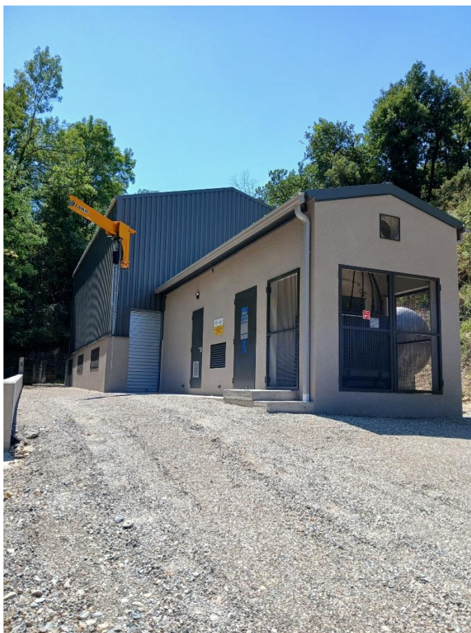
© SID Station de pompage de Papelissier Bas à Chatuzange-le-Goubet Chantier 2025/2026
