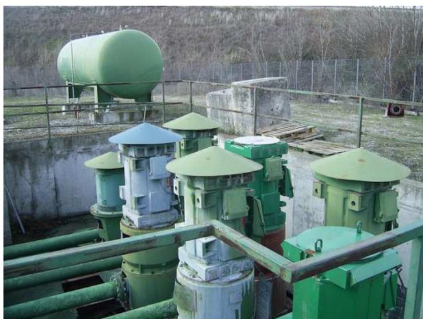
6 pompes Gourdin FE43 de 280 m<sup>3</sup>/h à 255 m HMT moteur 315 KW avec régulateur Claval
